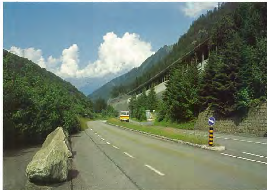
Caduta massi su strada cantonale, al di sopra della quale corre l'autostrada A2; Gurtellen UR, 1995.
