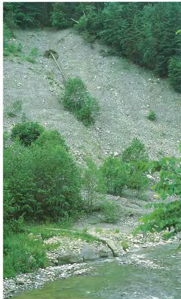
Erosioni e smottamenti; Les Paccots FR.
