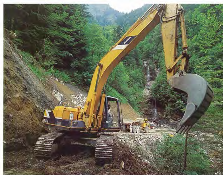
La costruzione di strade in montagna ha il più delle volte lo scopo di realizzare un allacciamento combinato di alpeggi e boschi; strada di Schwandenberg, Attinghausen UR.
