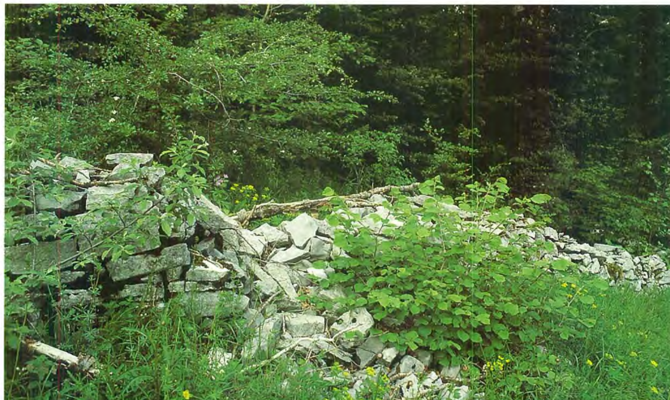
Resti di un muro a secco al margine di un bosco esposto a Sud; Saint-Cergue VD.
